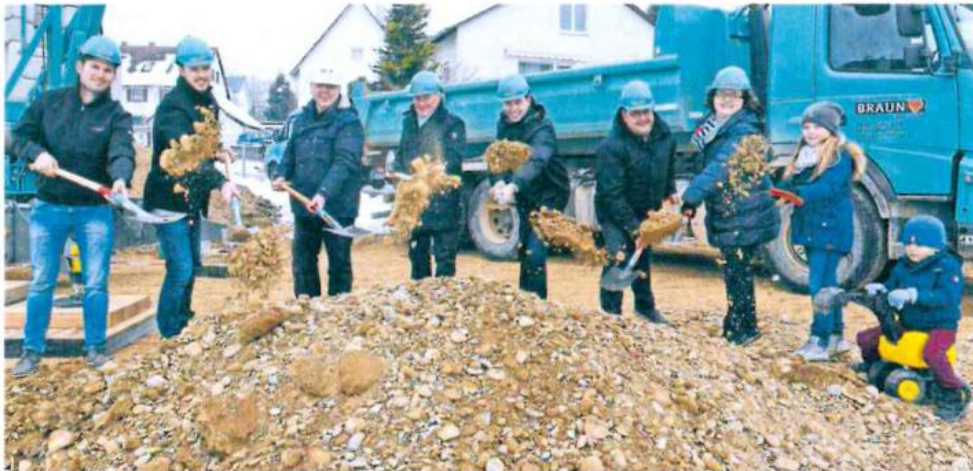
Packten beim Spatenstich für den Tagespflege-Neubau mit an: (von links) Claudius und Dominik Braun vom Bauunternehmen Braun aus Mietingen, Joseph Ludescher (Bauleiter vom Architekturbüro Mann und Partner), Bürgermeister Günther Karremann, CDU-Landtagsabgeordneter Thomas Dörflinger und die Bauherren Tobias und Heike Lerch mit ihren Kindern Pauline und Sebastian.
